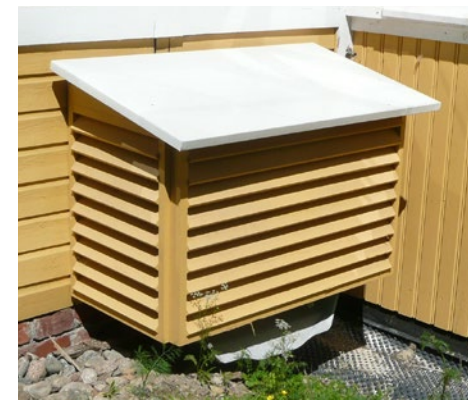
Hyvin suunniteltuna nykyaikainen talotekniikka voidaan toteuttaa historiallisessa ympäristössä lähes huomaamattomasti. Yläkuvassa ilmalämpöpumpun suojakotelo ja alakuvassa tekninen laite sekä johto rakennusaineisessa, julkisivun väriin maalatussa kotelossa.
