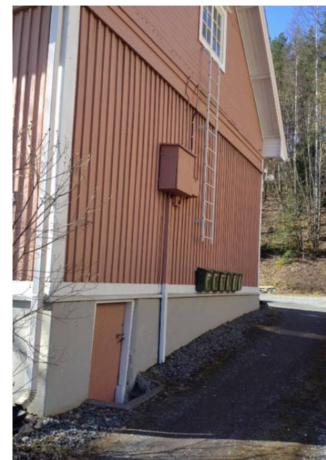
Hyvin suunniteltuna nykyaikainen talotekniikka voidaan toteuttaa historiallisessa ympäristössä lähes huomaamattomasti. Yläkuvassa ilmalämpöpumpun suojakotelo ja alakuvassa tekninen laite sekä johto rakennusaineisessa, julkisivun väriin maalatussa kotelossa.
